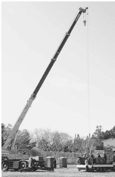
仮設住宅の建設が始まった市民運動公園
